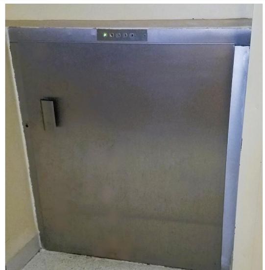
**Figure N°1** : Monte-charge assurant le transport des spécimens au sein du laboratoire (Réf : laboratoire d'anatomie et cytologie pathologiques, CHU FES).
