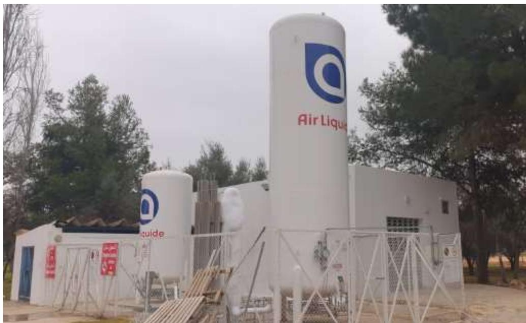
*Figure 8. Deux réservoirs de stockage d'oxygène liquide cryogénique à l'HMMI*
